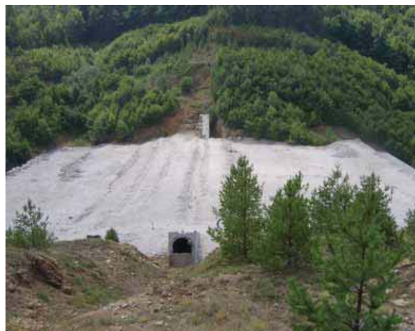
Фиг.6. Яз.стена „Нейковци – в строителство
