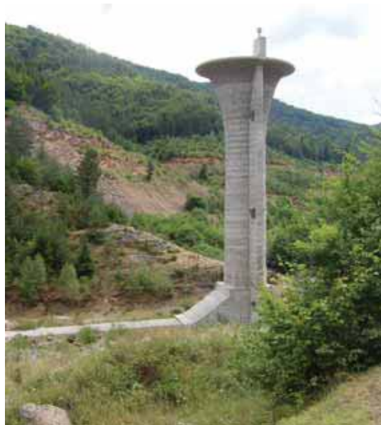
Фиг. 5. Преливна и водоземна кула на яз. „Пловдивци”
