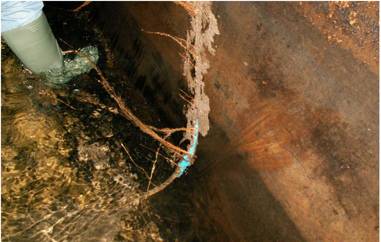
Сн.5 - Обработвана фуга – работи и се виждат корени проникнали през пукнатините.
