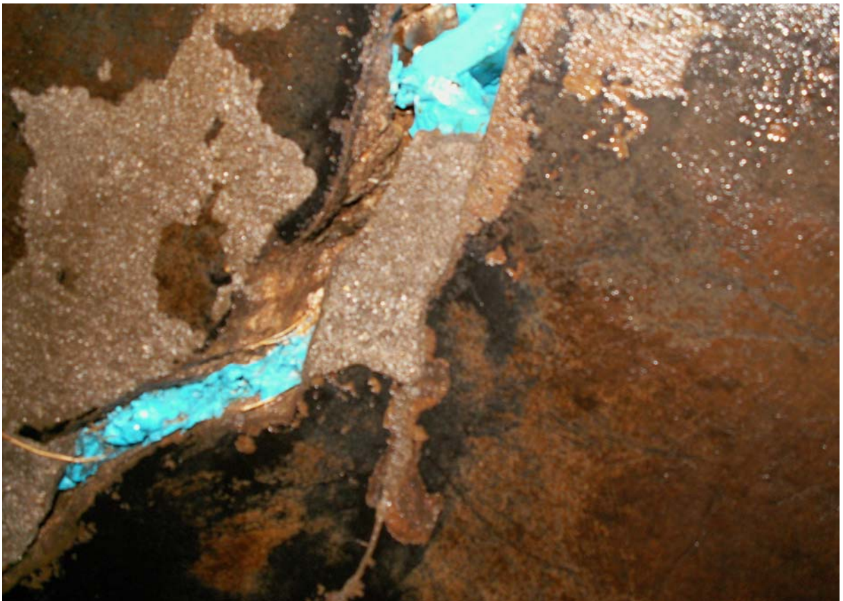
Сн.6 - Канал Железница – обработена фуга , но компрометирана
